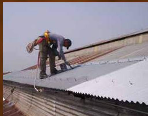
El esquema Converttech Z + Converttech Plata ha sido utilizado exitosamente en muchas obras para recuperar techos de chapa, in situ, evitando la parada operativa y con un costo aprox. a 1/3 de la renovación de las mismas.
