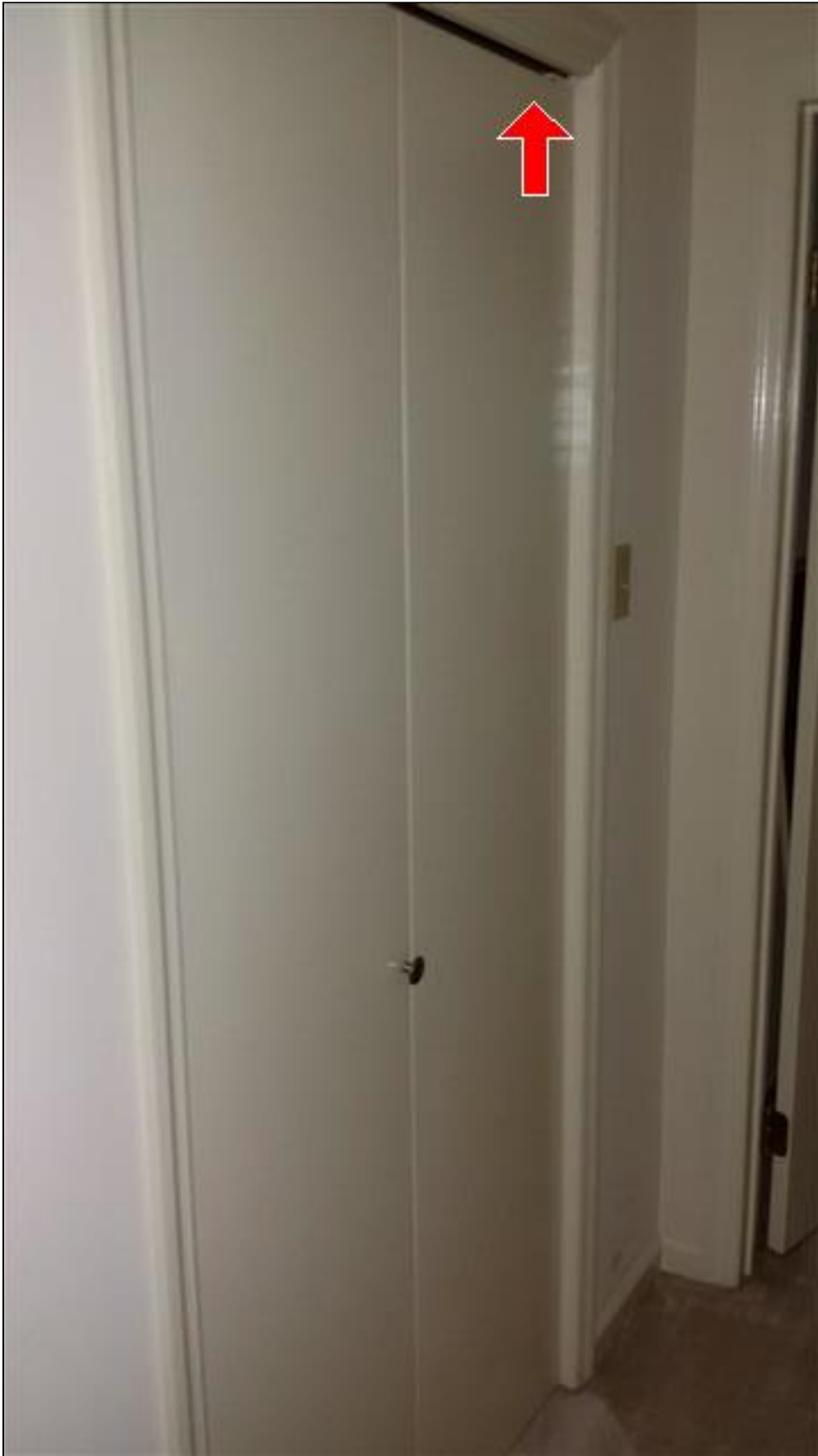
4.5 Item 1(Picture) hallway closet door
