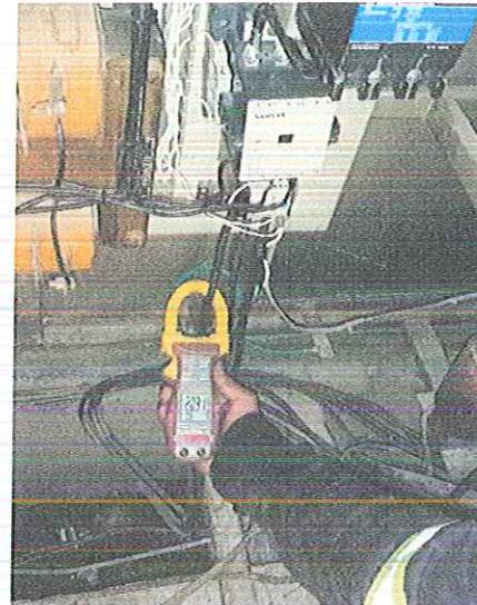
**SERVICIOS DE EXTRACCION, TRASLADOS Y MANIOBRAS DE CARGA-DESCARGA, MANTENIMIENTO Y PRUEBAS DE PUESTA EN SERVICIO A ARRANCADOR Y BOMBA VFH 15 HP/440 V, DEL REBOMBEO TECNOLÓGICO DE , LOCALIZADO EN PERIFERICO NORTE DE ESTA CIUDAD DE IGUALA GRO**
