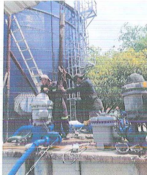
SERVICIOS DE EXTRACCION, TRASLADOS Y MANIOBRAS DE CARGA-DESCARGA, MANTENIMIENTO Y PRUEBAS DE PUESTA EN SERVICIO A ARRANCADOR Y BOMBA VFH 15 HP/440 V, DEL REBOMBEO TECNOLÓGICO DE , LOCALIZADO EN PERIFERICO NORTE DE ESTA CIUDAD DE IGUALA GRO
