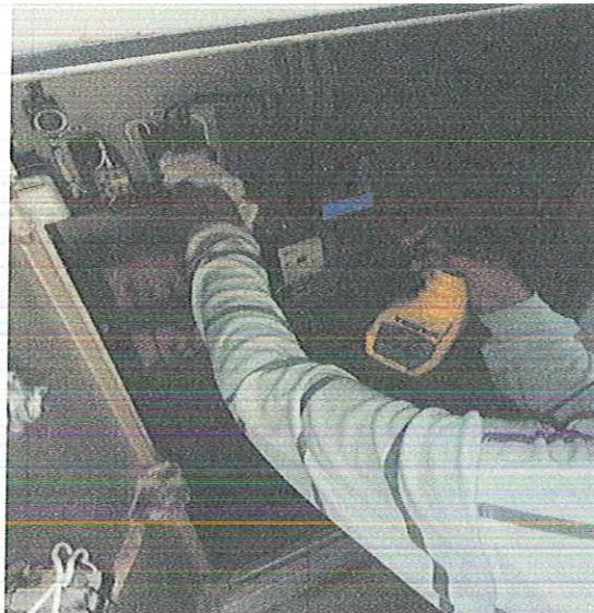
SERVICIOS DE EXTRACCIÓN, TRASLADOS Y MANIOBRAS DE CARGA-DESCARGA, MANTENIMIENTO Y PRUEBAS DE PUESTA EN SERVICIO A ARRANCADOR Y BOMBA VFH 15 HP/440 V, DEL REBOMBEO TECNOLÓGICO DE, LOCALIZADO EN PERIFÉRICO NORTE DE ESTA CIUDAD DE IGUALA GRO
