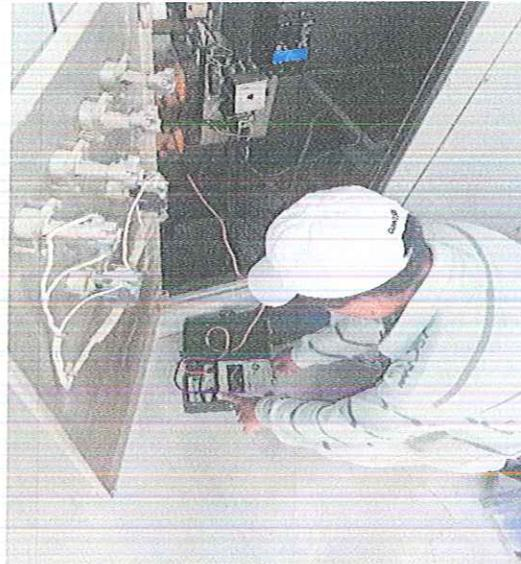
SERVICIOS DE EXTRACCION, TRASLADOS Y MANIOBRAS DE CARGA-DESCARGA, MANTENIMIENTO Y PRUEBAS DE PUESTA EN SERVICIO A ARRANCADOR Y BOMBA VFH 15 HP/440 V, DEL REBOMBEO TECNOLÓGICO DE , LOCALIZADO EN PERIFERICO NORTE DE ESTA CIUDAD DE IGUALA GRO
