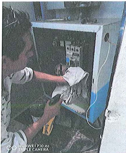
MONTAJE ELECTROMECANICO DE UNA BOMBA SUMERGIBLE 30 HP/220V- 84 MT DE COLUMNA ACERO AL CARBON 4", EN BOMBEO POZO PROFUNDO 1 MYO LOCALIZADO EN LA COL. 1 MYO DE ESTA CD. IGUALA GRO.
