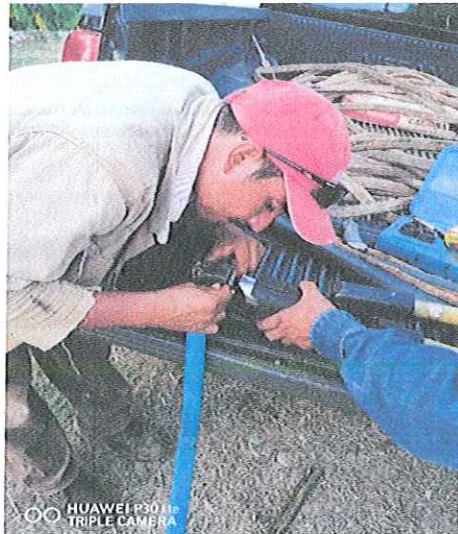
MONTAJE ELECTROMECHANICO DE UNA BOMBA SUMERGIBLE 30 HP/220V- 84 MT DE COLUMNA ACERO AL CARBON 4", EN BOMBEO POZO PROFUNDO 1 MYO LOCALIZADO EN LA COL. 1 MYO DE ESTA CD. IGUALA GRO.
