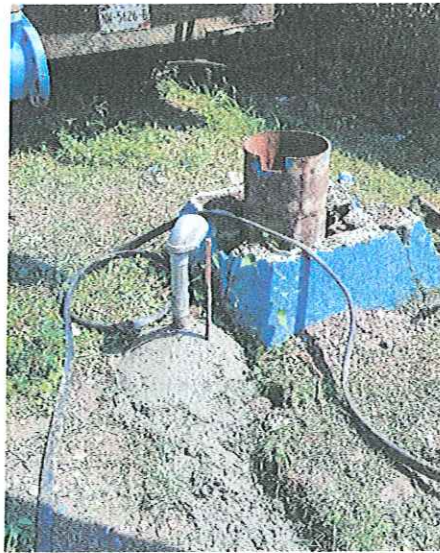
MONTAJE ELECTROMECHANICO DE UNA BOMBA SUMERGIBLE 30 HP/220V- 84 MT DE COLUMNA ACERO AL CARBON 4", EN BOMBEO POZO PROFUNDO 1 MYO LOCALIZADO EN LA COL. 1 MYO DE ESTA CD. IGUALA GRO.
