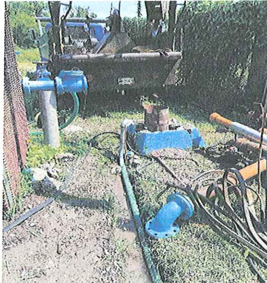
MONTAJE ELECTROMECANICO DE UNA BOMBA SUMERGIBLE 30 HP/220V- 84 MT DE COLUMNA ACERO AL CARBON 4", EN BOMBEO POZO PROFUNDO 1 MYO LOCALIZADO EN LA COL. 1 MYO DE ESTA CD. IGUALA GRO.
