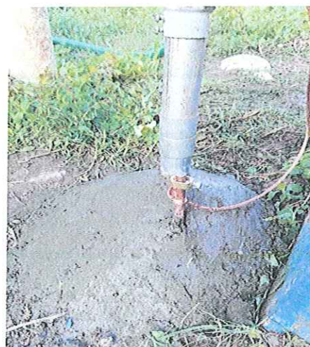
MONTAJE ELECTROMECHANICO DE UNA BOMBA SUMERGIBLE 30 HP/220V- 84 MT DE COLUMNA ACERO AL CARBON 4", EN BOMBEO POZO PROFUNDO 1 MYO LOCALIZADO EN LA COL. 1 MYO DE ESTA CD. IGUALA GRO.
