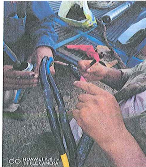
MONTAJE ELECTROMECHANICO DE UNA BOMBA SUMERGIBLE 30 HP/220V- 84 MT DE COLUMNA ACERO AL CARBON 4", EN BOMBEO POZO PROFUNDO 1 MYO LOCALIZADO EN LA COL. 1 MYO DE ESTA CD. IGUALA GRO.
