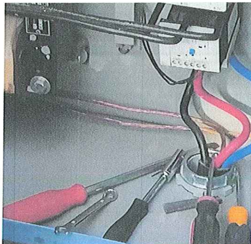
MONTAJE ELECTROMECHANICO DE UNA BOMBA SUMERGIBLE 30 HP/220V- 84 MT DE COLUMNA ACERO AL CARBON 4", EN BOMBEO POZO PROFUNDO 1 MYO LOCALIZADO EN LA COL. 1 MYO DE ESTA CD. IGUALA GRO.
