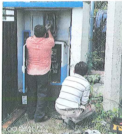
MONTAJE ELECTROMECANICO DE UNA BOMBA SUMERGIBLE 30 HP/220V- 84 MT DE COLUMNA ACERO AL CARBON 4", EN BOMBEO POZO PROFUNDO 1 MYO LOCALIZADO EN LA COL. 1 MYO DE ESTA CD. IGUALA GRO.
