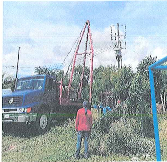
MONTAJE ELECTROMECANICO DE UNA BOMBA SUMERGIBLE 30 HP/220V- 84 MT DE COLUMNA ACERO AL CARBON 4", EN BOMBEO POZO PROFUNDO 1 MYO LOCALIZADO EN LA COL. 1 MYO DE ESTA CD. IGUALA GRO
