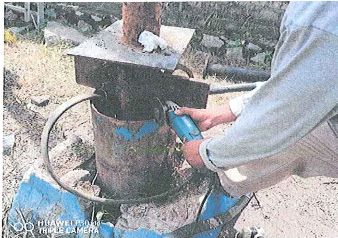
MONTAJE ELECTROMECANICO DE UNA BOMBA SUMERGIBLE 30 HP/220V- 84 MT DE COLUMNA ACERO AL CARBON 4", EN BOMBEO POZO PROFUNDO 1 MYO LOCALIZADO EN LA COL. 1 MYO DE ESTA CD. IGUALA GRO
