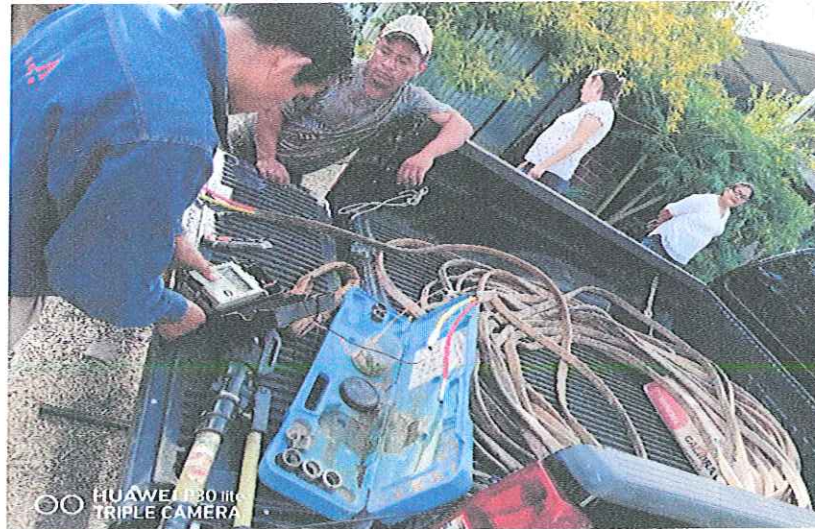
MONTAJE ELECTROMECANICO DE UNA BOMBA SUMERGIBLE 30 HP/220V- 84 MT DE COLUMNA ACERO AL CARBON 4",EN BOMBEO POZO PROFUNDO 1 MYO LOCALIZADO EN LA COL. 1 MYO DE ESTA CD. IGUALA GRO
