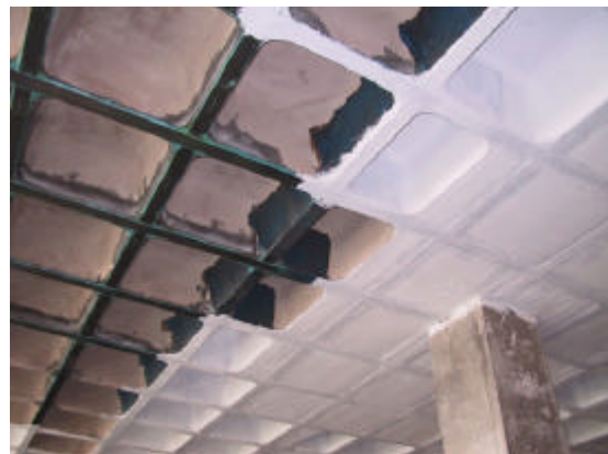
Ilustración 2.- Refuerzo a flexión en forjado reticular bidireccional.
