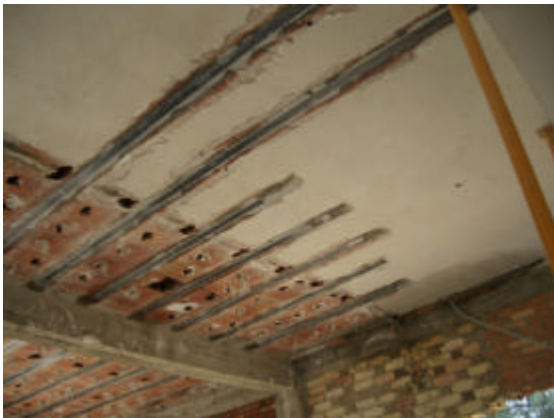
Ilustración 1.- Refuerzo a flexión en forjado unidireccional.
