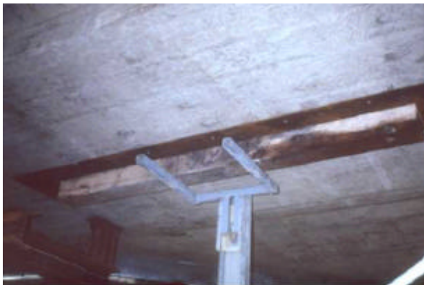
Ilustración 1.- Apuntalamiento de chapa metálica.
