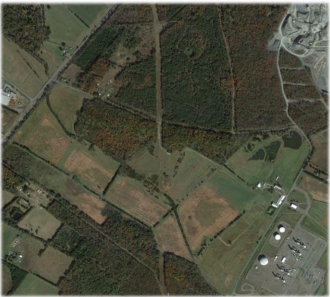
Remington Solar 20 MW Fauquier County
