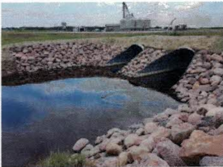
1-Culvert Hwy 45 & 29.jpeg 412K
