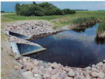
2 -Culvert Hwy 45 & 29.jpeg 485K
