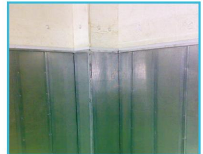
下方外覆沖孔板 (防破壞) 上方僅包玻璃纖維
