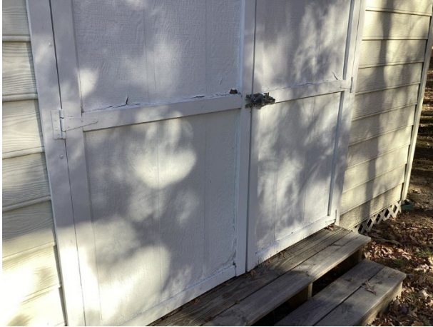
Door deterioration
