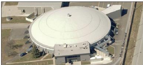
Dome Arena - Henrietta, NY
