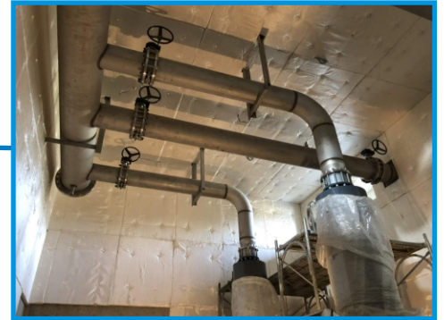
吸音壁面及平頂 (降低機房噪音)
