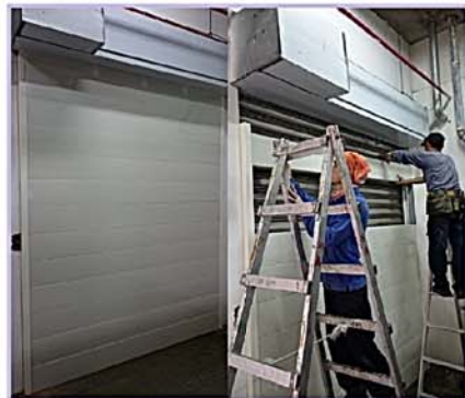
鐵捲門加裝活動式隔音板
