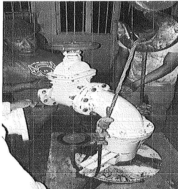
"SUMINISTRO, MONTAJE ELECTROMECANICO Y PRUEBAS DE UNA MOTOBOMBA SUMERGIBLE 40HP/440 V-150 MTS DE COLUMNA ACERO AL CARBON 6 ", EN BOMBEO POZO PROFUNDO 1, LOCALIZADO EN MAYA No. 1 OFICINAS DE CAPAMI, EN LA CIUDAD DE IGUALA GRO".
