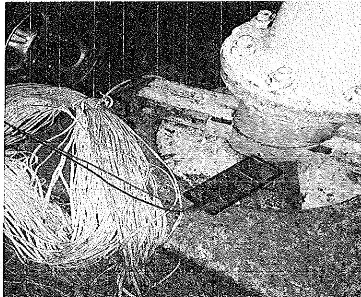
"SUMINISTRO, MONTAJE ELECTROMECANICO Y PRUEBAS DE UNA MOTOBOMBA SUMERGIBLE 40HP/440 V-150 MTS DE COLUMNA ACERO AL CARBON 6 ", EN BOMBEO POZO PROFUNDO 1, LOCALIZADO EN MAYA No. 1 OFICINAS DE CAPAMI, EN LA CIUDAD DE IGUALA GRO".
