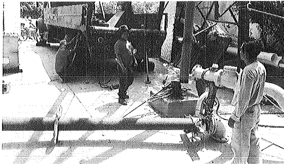
"SUMINISTRO, MONTAJE ELECTROMECANICO Y PRUEBAS DE UNA MOTOBOMBA SUMERGIBLE 40HP/440 V-150 MTS DE COLUMNA ACERO AL CARBON 6 ", EN BOMBEO POZO PROFUNDO 1, LOCALIZADO EN MAYA No. 1 OFICINAS DE CAPAMI, EN LA CIUDAD DE IGUALA GRO".
