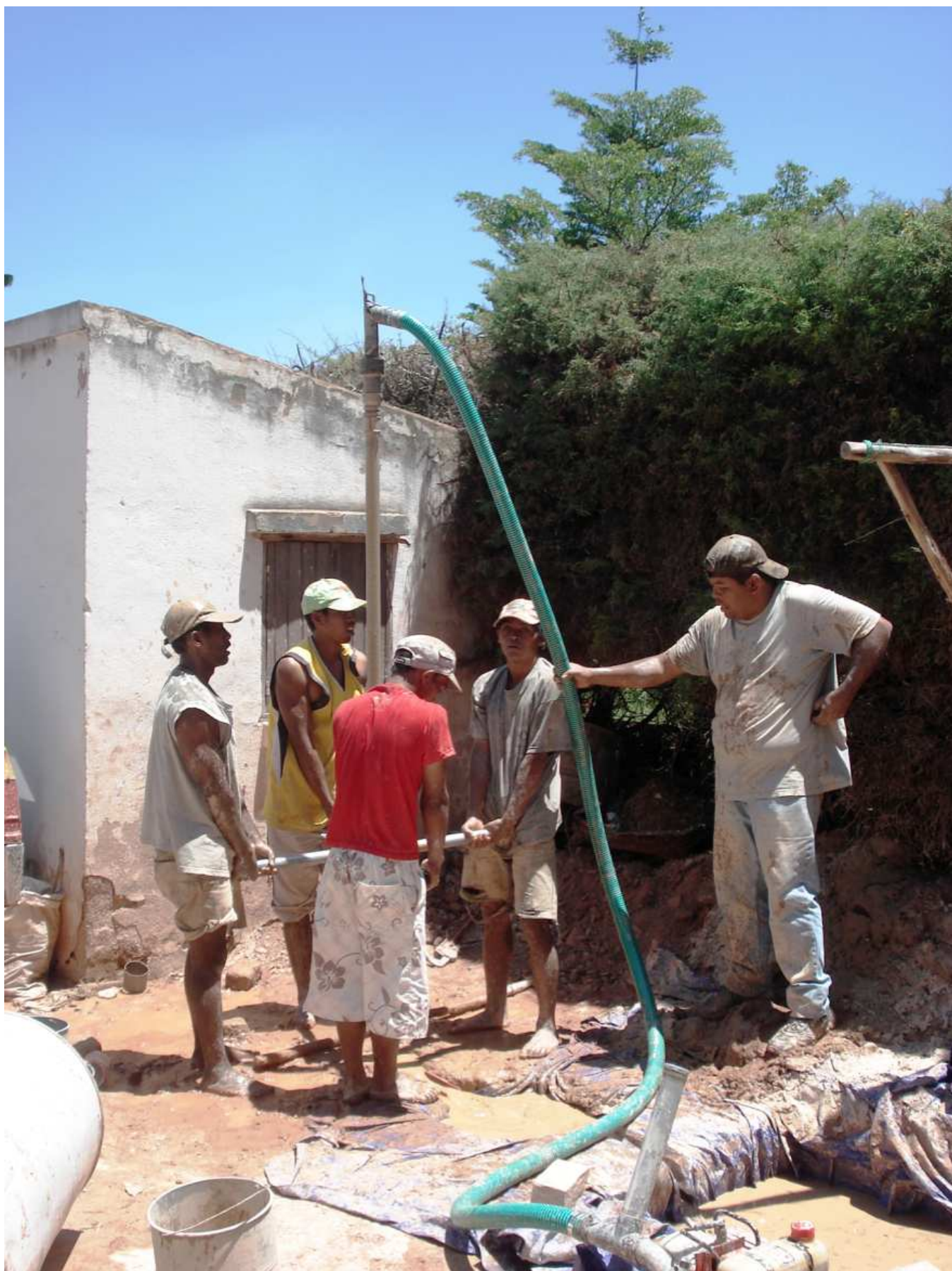
Figure 1. Méthode de forage à la boue : rotary manuel
