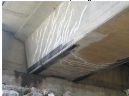
Ilustración 6.- Refuerzo por cosido recto, en zona de biela comprimida en apoyo.
