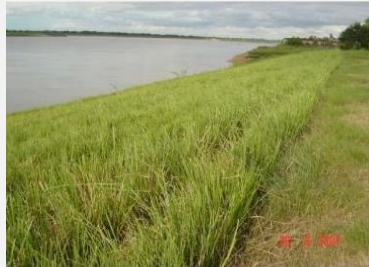
Estabilización de las riberas del río (Malaysia), Del Rio Mekong Cambodia.
