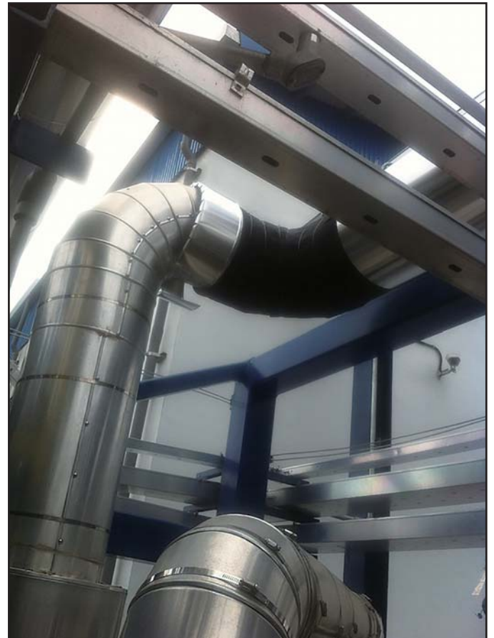
隔音外包覆0.4mmt 鋁皮或不鏽鋼鐵皮
