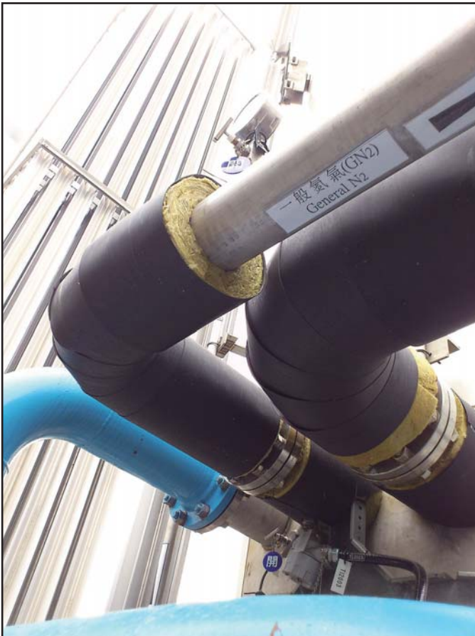
高速氣體管外覆60K岩棉及2層遮音片
