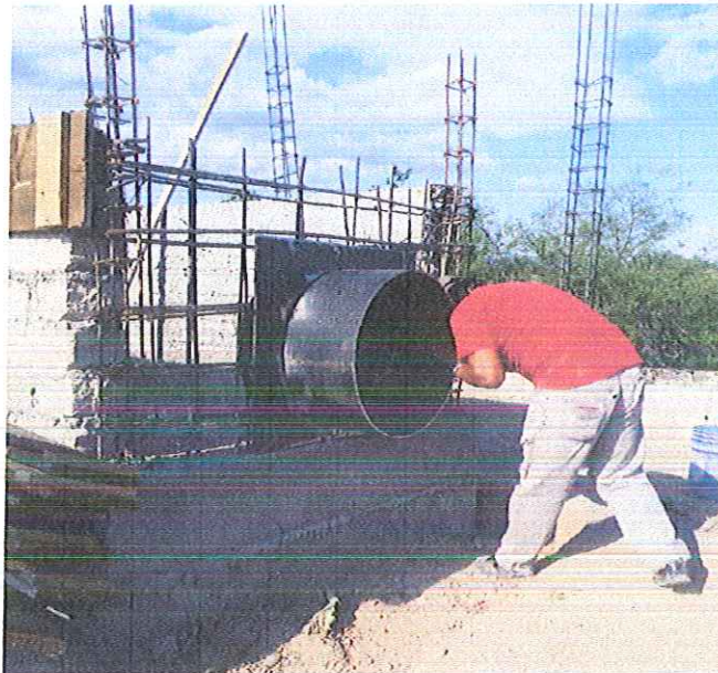
E02 SUMINISTRO Y COLOCACION DE TUBERIA DE ACERO AL CARBON DE 24" CEDULA 40 INCLUYE: MATERIAL, MANO DE OBRA, HERRAMIENTA
