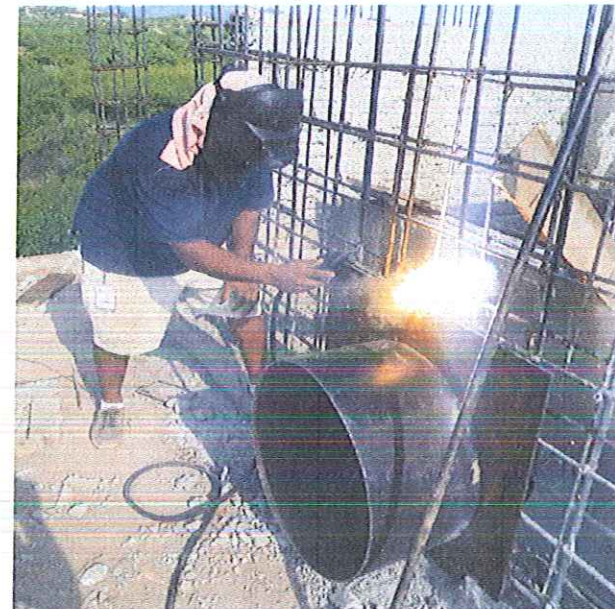
E02 SUMINISTRO Y COLOCACION DE TUBERIA DE ACERO AL CARBON DE 24" CEDULA 40 INCLUYE: MATERIAL, MANO DE OBRA, HERRAMIENTA
