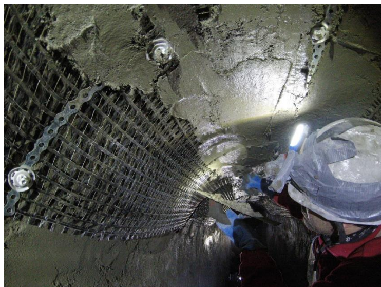
Refuerzo de muro de galería con malla Master Brace NET
