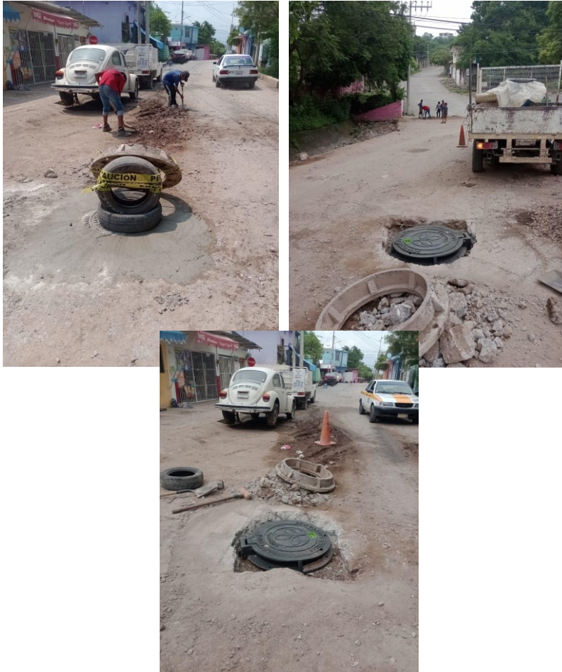
Instalación de tapa de pozo de visita en la Col. Burócrata.
