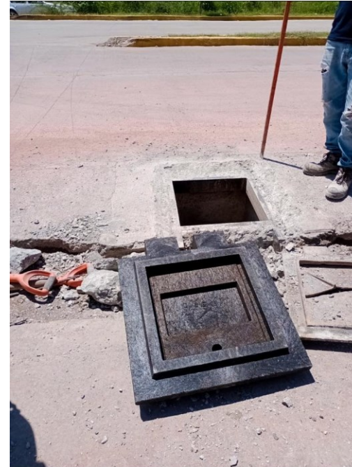
Instalación de tapa metálica en la entrada de la Col. PPG.
