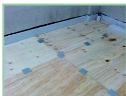
4. 木夾板固定片固定
