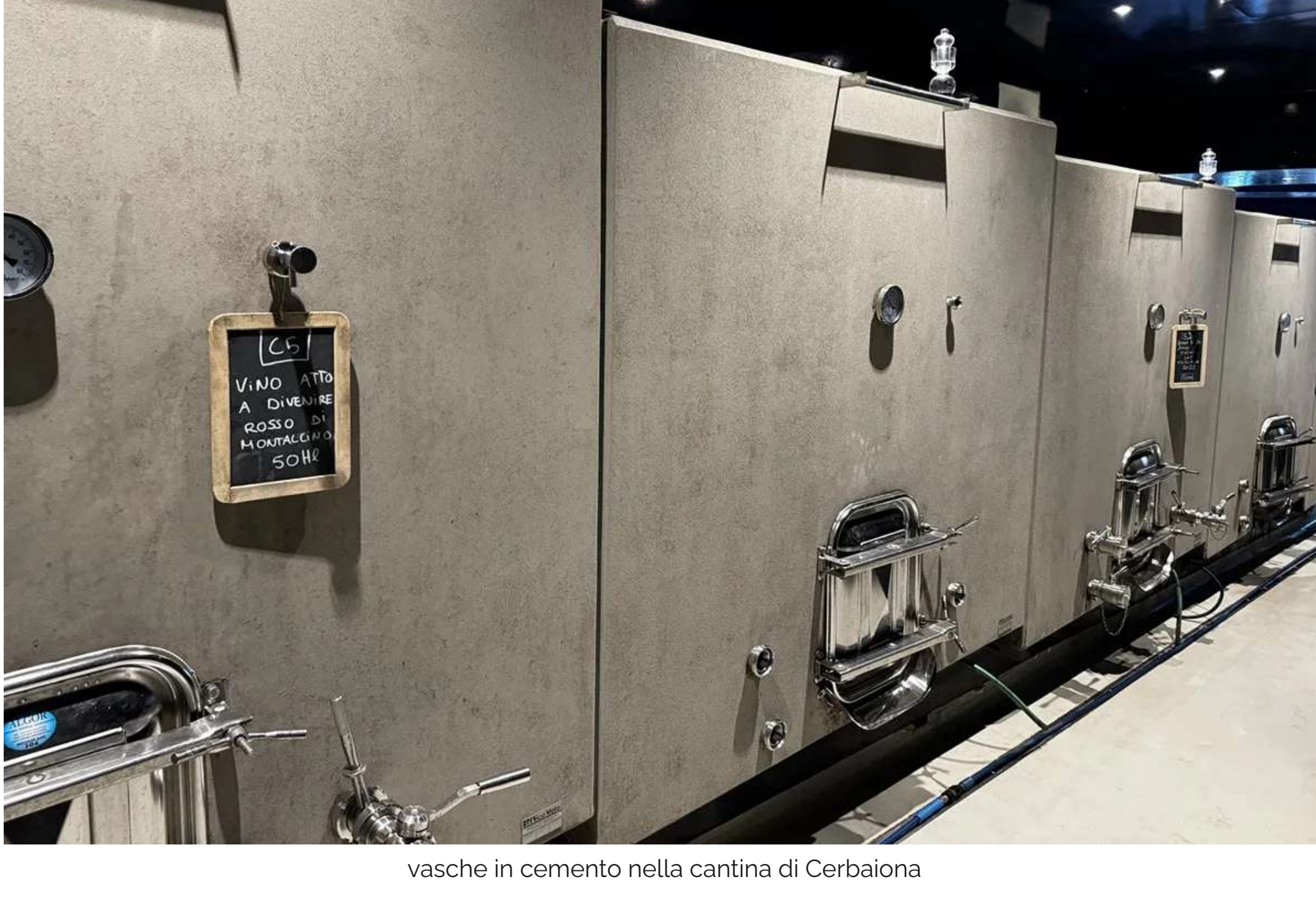
vasche in cemento nella cantina di Cerbaiona
